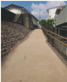
車椅子用スロープ （岐阜公園、第一駐車場南）
