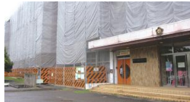
旧徹明小学校・廃校舎
